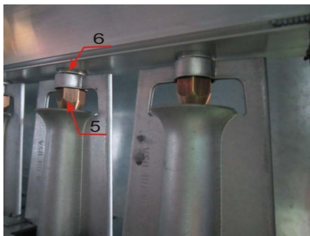
Рисунок 10.1.2 10 Переход на другой вид газа
